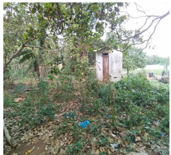
Photo 2 : Une toilette abandonnée.
